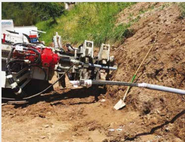
<< Ancoraggi Flottanti realizzati con unità di perforazione a rotopercolazione esterna della lunghezza di 55 m. Ancoraggio composito ø76 mm, bit ø140 mm, forza massima 3200 kN. << Floating anchor produced with a 55 m-long external rotary percussion drilling unit. Composite anchor ø76 mm, bit ø140 mm, maximum strength 3200 kN.
