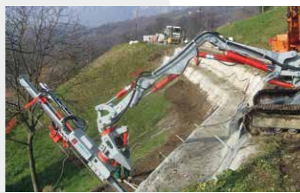
<< Ancoraggi Flottanti realizzati con unità di perforazione a rotopercolazione esterna della lunghezza di 55 m. Ancoraggio composito ø76 mm, bit ø140 mm, forza massima 3200 kN. << Floating anchor produced with a 55 m-long external rotary percussion drilling unit. Composite anchor ø76 mm, bit ø140 mm, maximum strength 3200 kN.
